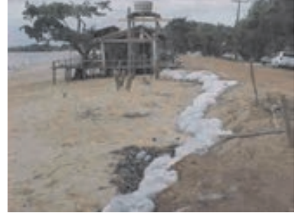
Estampa 3. Sacos de areia como forma de proteção da linha de costa na praia do Marahú (Ilha do Mosqueiro – PA).
