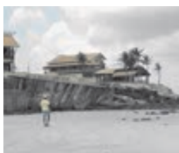
Estampa 4. Destruição da cerca de proteção da casa na praia do Atalaia (Salinópolis – PA).
