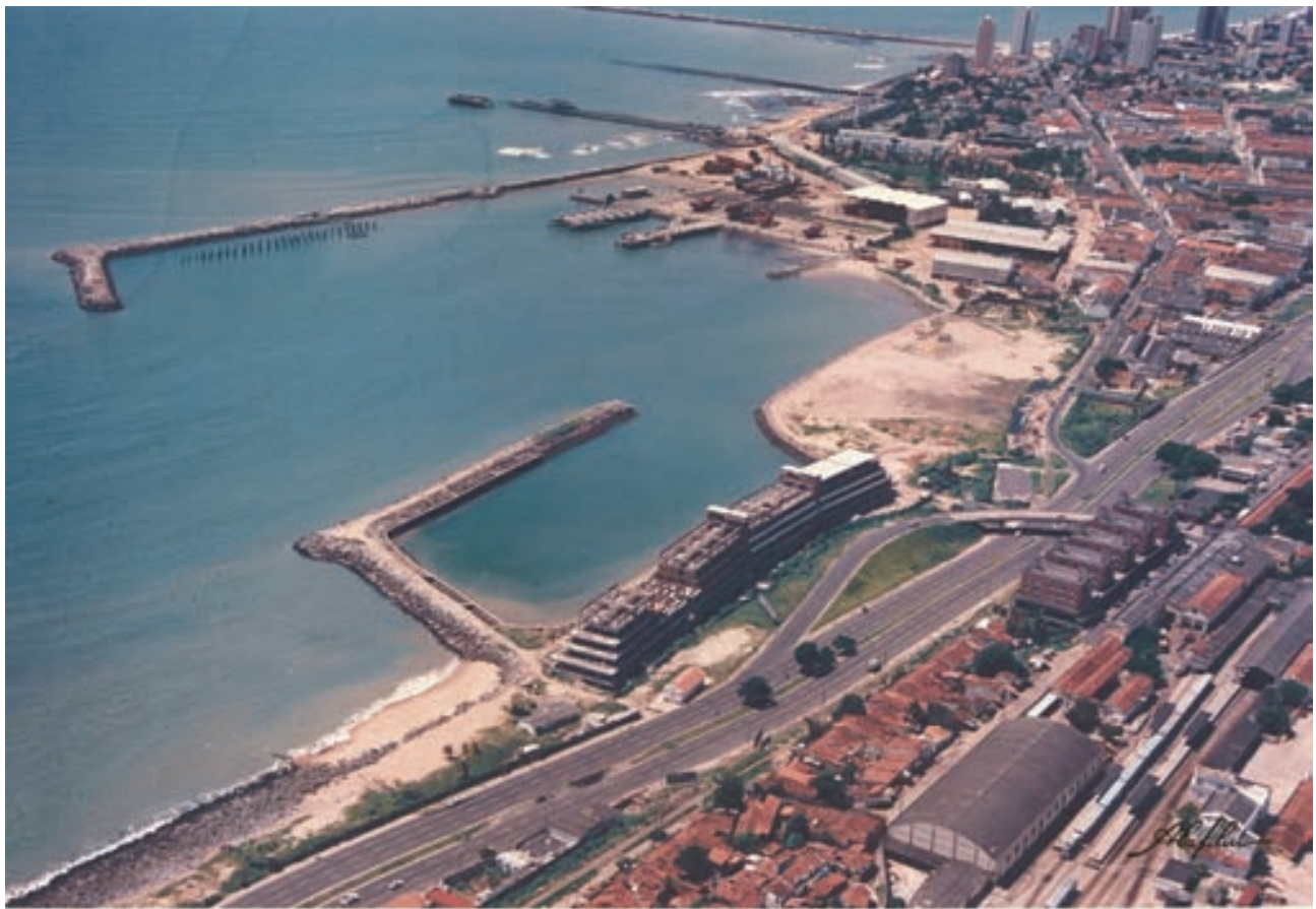
Figura 8. Série de espigões construídos para diminuir os efeitos erosivos decorrentes da construção do Porto de Mucuripe em Fortaleza. O antigo Porto de Fortaleza foi aproveitado para a construção de marinas associado a um empreendimento hoteleiro de grande porte.
