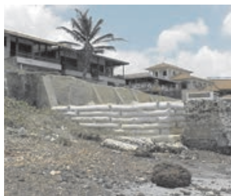
Estampa 2. Sacos de areia como forma de proteção às atividades erosivas na praia do Atalaia (Salinópolis – PA).
