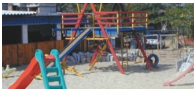
Figura 18. Itaipuaçu. Erosão do topo do cordão pr transposição de ondas evidenciado pela colocação de sacos de areia como medida de proteção
