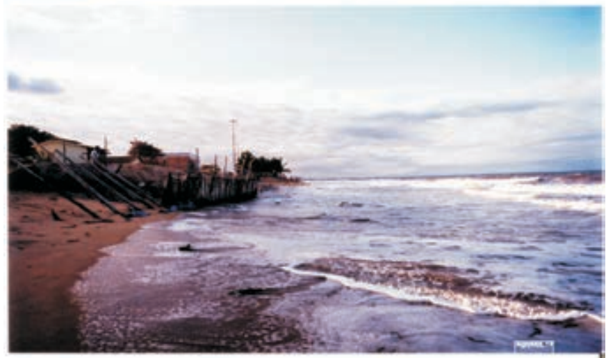
C. Praia da Bugia, em Conceição da Barra. Destruição das residências da rua à beira mar e tentativas de contenção da erosão pela população local. (Agosto de 2000)
