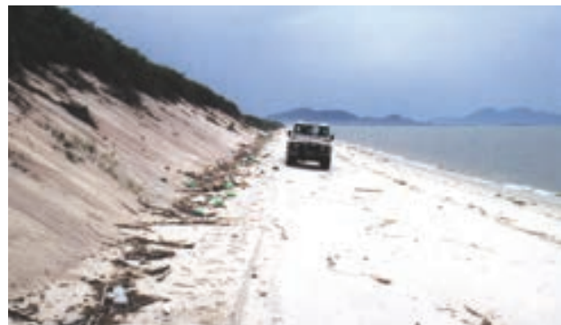
Figura 26. Erosão no flanco lagunar no cordão litorâneo da Marambaia
