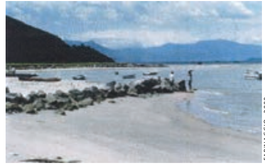
Figuras 31 c, d. Respectivamente, uma vista geral da Ponta do Camaroeiro, com destaque para a grande quantidade de material concentrado no molhe do rio Ipiranga, e o detalhe de um dos espigões construídos nesta praia.
