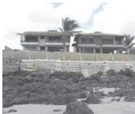
Estampas 5 e 6. Enrocamentos e sacos de areia como forma de proteção às atividades erosivas na praia do Atalaia (Salinópolis – PA).
