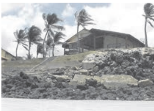
Estampas 5 e 6. Enrocamentos e sacos de areia como forma de proteção às atividades erosivas na praia do Atalaia (Salinópolis – PA).
