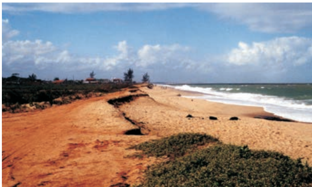
Figura 9. Lagomar. Erosão do topo de cordão com tendência transgressiva
