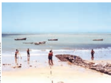
Figura 9. Fotos mostrando a deteriorização das estruturas de concreto (A) e ineficiência dos mesmos (B) para conter o avanço do mar em Caiçara do Norte-RN. Fotos de Tabosa no mesmo local na baixamar (A) e na preamar (B). Entre 1965 e 1989 esta praia sofreu uma retração de 200 m (Tabosa, 2000; Vital et al., 2002c).
