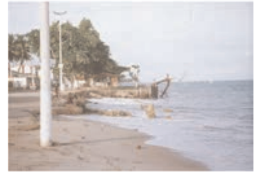
Figura 8. Processo erosivo instalado na praia de Paripueira. Vista para norte, em março de 1999.
