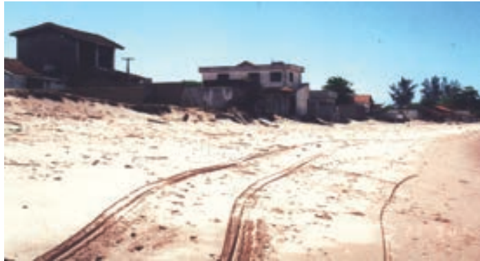
Figura 4. A construção de casas junto ao limite da berma da praia resulta em situação de risco numa praia com tendência erosiva (proximidades de Santa Clara, entre Guaxindiba e Gargaú).
