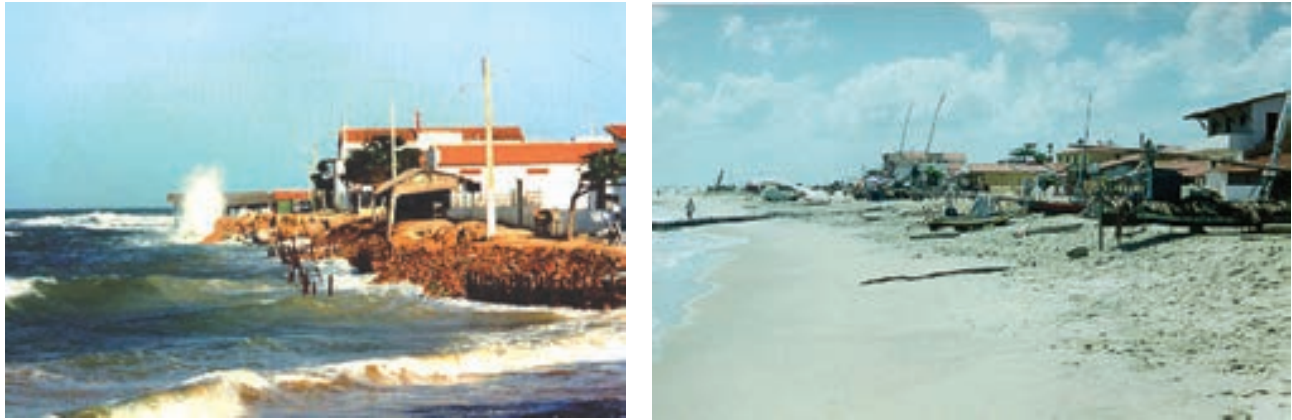
Figura 10. Reabilitação da Praia da Caponga através da implantação de gabiões e alimentação artificial (1993–2001). Fonte: Pinheiro et al. (2003).
