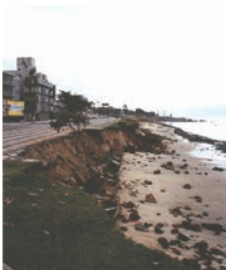
Figura 34. Erosão na parte norte da Praia Brava de Caiobá após a ressaca de maio de 2001.
