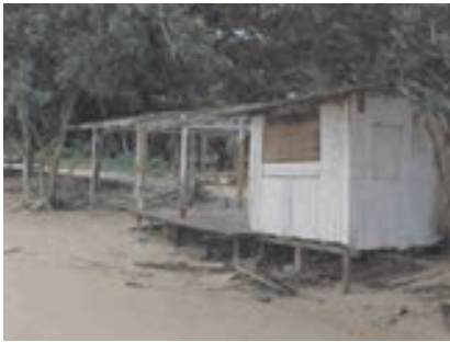
Estampa 4. Erosão costeira mostrando o recuo da praia em direção à estrada na praia do Marahú (Ilha do Mosqueiro – PA).
