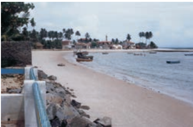
Figura 4. Obras de contenção marinha na praia de Coruripe. Vista para norte, em outubro de 2000.
