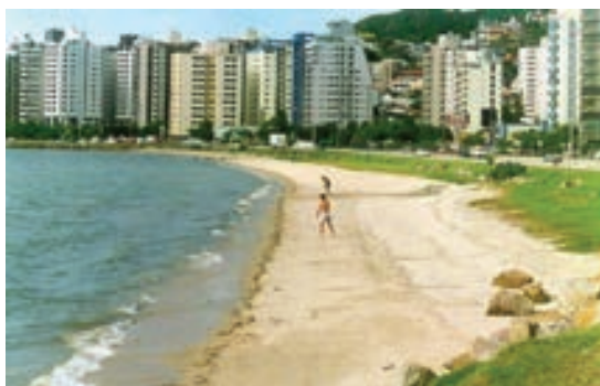
Figura 12. Visão para norte da praia de São Luiz junto à baía Norte, observando-se no centro da praia, efluentes do esgoto doméstico.
