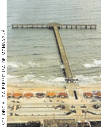
Figura 25a. Plataforma de Pesca no bairro de Agenor de Campos, município de Mongaguá. Esta construção foi efetuado na década de 1970, com pilares vazados (detalhes nas figuras 19b e 19c) e trouxe um pequeno avanço da linha de costa devido ao amortecimento da energia de ondas no pilares.
