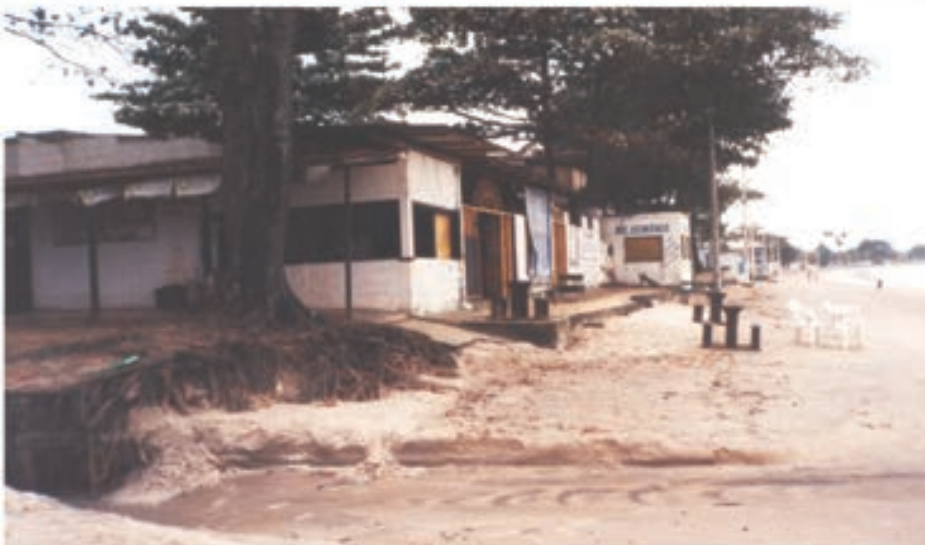
B. Praia de Santa Mônica, em Guarapari. Praia dissipativa com urbanização sobre o pós-praia e dunas frontais. Erosão acentuada nos locais dos sangradouros. (Agosto de 2000)
