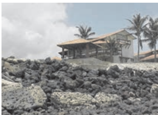
Estampa 1. Enrocamentos substituindo o muro de arrimo destruído como forma de proteção às atividades erosivas na praia do Atalaia (Salinópolis – PA).
