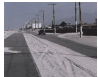
Figura 27b. Migração da areia de praia para as ruas adjacentes à mesma.
