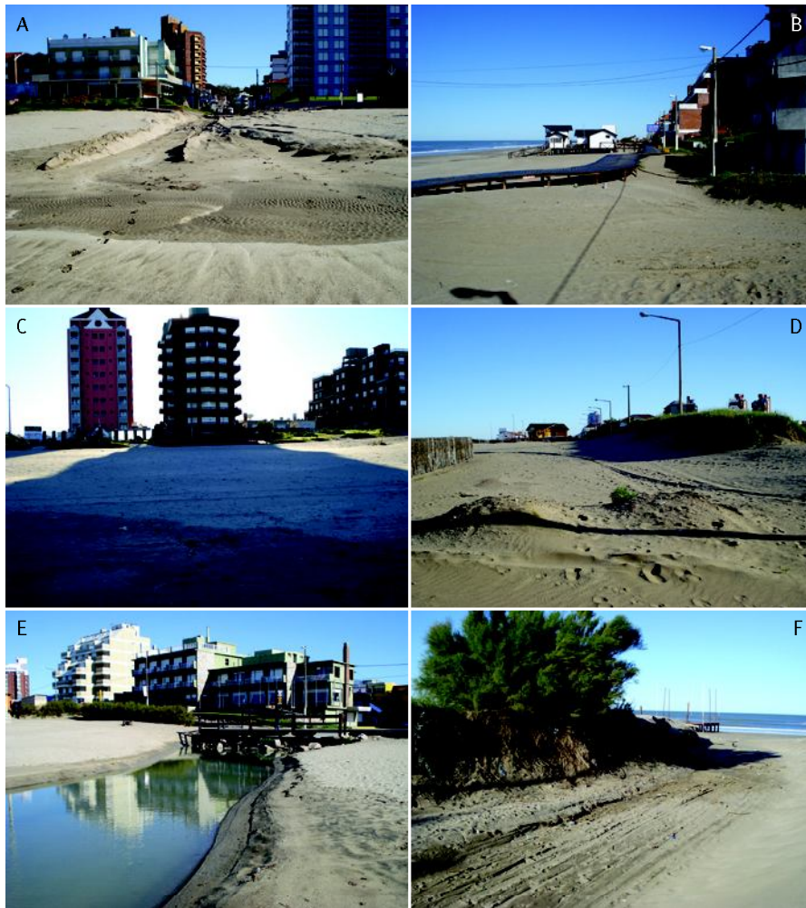
Fig. 5 - Villa Gesell, Argentina. a: Cortes pluviales sobre playa posterior y berma; b: desmonte de médanos para urbanización; c: avance de la urbanización sobre médanos y playas; d: corte en médanos discontinuos parcialmente vegetados; e: pluvial inundado por sobrelavados; f: eliminación parcial de médano para ingreso vehicular.
