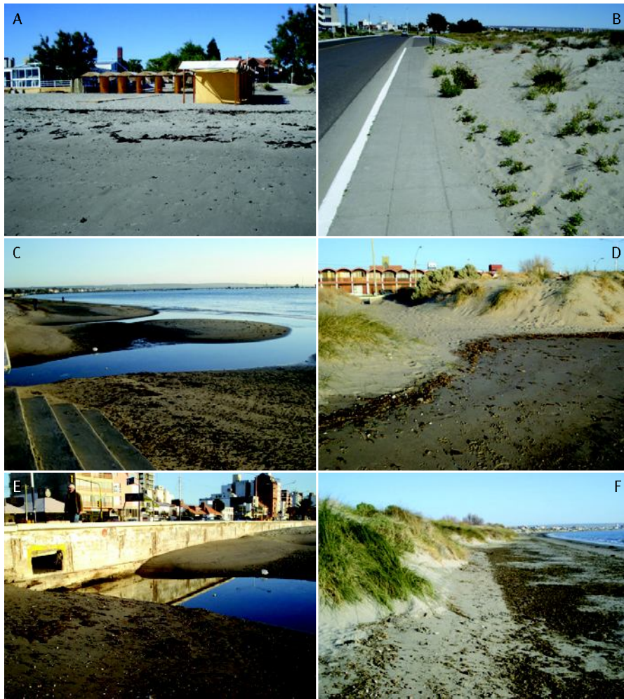
Fig. 1 - Puerto Madryn. a: Balnearios sobre sectores de médanos; b: paseo peatonal y camino costero; c: erosión sobre playas por salida pluvial; d: corte en médanos para ingreso peatonal; e: afectación de pluviales entubados; f: escarpas en la base de los médanos.
