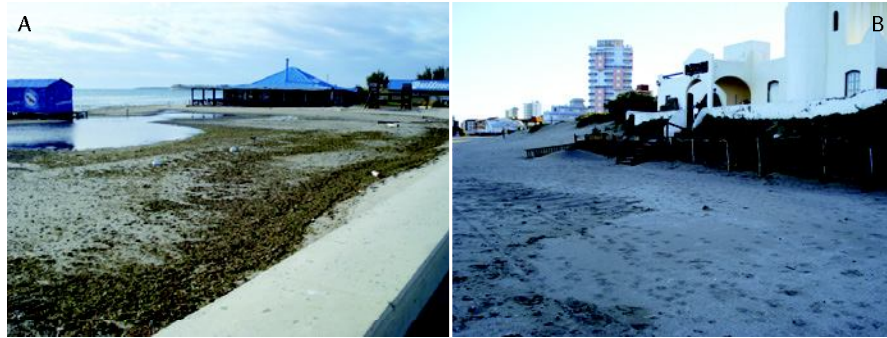
Fig. 8 - Interrupción de la continuidad de las geoformas de acumulación costera y afectación en el transporte natural de arenas en playas y médanos por acción antrópica sobre el litoral en Puerto Madryn (A), y Villa Gesell (B).
