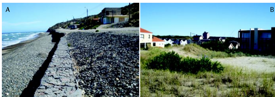
Fig. 9 - Evidencias de erosión natural e inducida en litorales urbanizados pampeanos y patagónicos, con vocación turística. (A) Erosión marina activa y obras de protección en Playa Magagna, Chubut; (B) Desmonte de médanos costeros para urbanización en Mar Azul, Buenos Aires.
