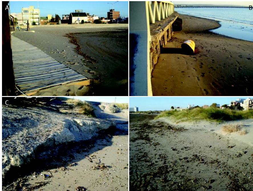
Fig. 4 - Puerto Madryn. a: Ingreso de marea extraordinaria a zona de balnearios; b: desaparición de playa posterior y erosión en base de muro; c: escarpa de erosión; d: base de frente de dunas cubierta por marea extraordinaria.
